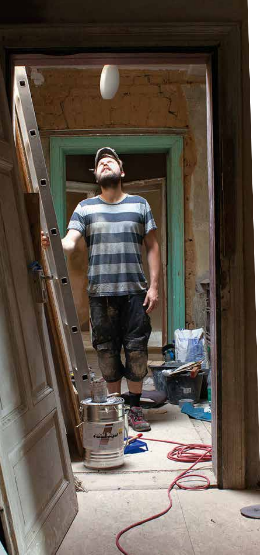
▲ Ein enger Flur führt in viele Zimmer, in denen jeder für sich wohnt? Nicht so in der KunterBunten 19. Bei der Grundsanierung des vierstöckigen Hauses wurde mit diversen Wanddurchbrüchen mehr Raum für gemeinschaftliches Wohnen geschaffen.
